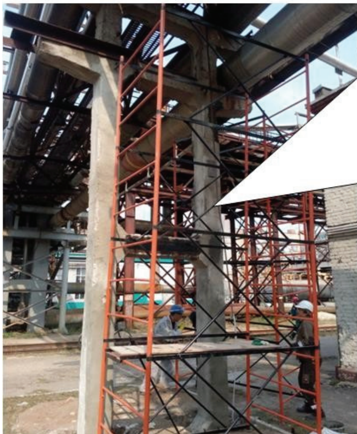
Рис. 3 – Наклейка на распорки и стойки эстакад специализированных композитных материалов, выполненных в виде лент из углепластика
