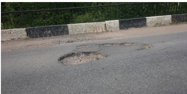
Рисунок 5. Ямочность из-за ударного динамического действия (Фотография сделана авторами)
