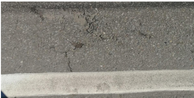
Рисунок 4. Выкрашивание из-за потери свойств битума (Фотография сделана авторами)
