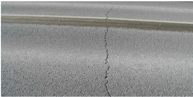
Рисунок 3. Температурные трещины (Фотография сделана авторами)
