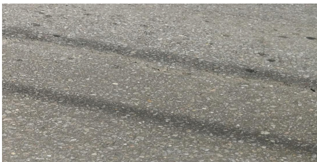
Рисунок 2. Поверхностное пластическое колееобразование (Фотография сделана авторами)
